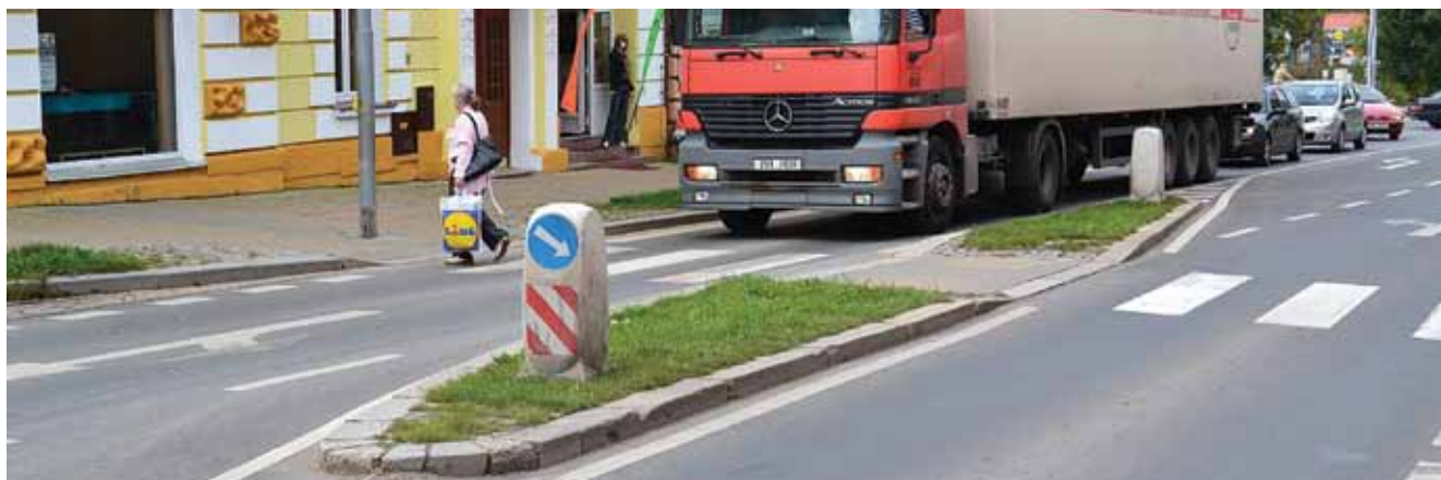
obr. 11 Dělicí ostrůvek s přechodem pro chodce (Mariánské Lázně, ul. Chebská)
