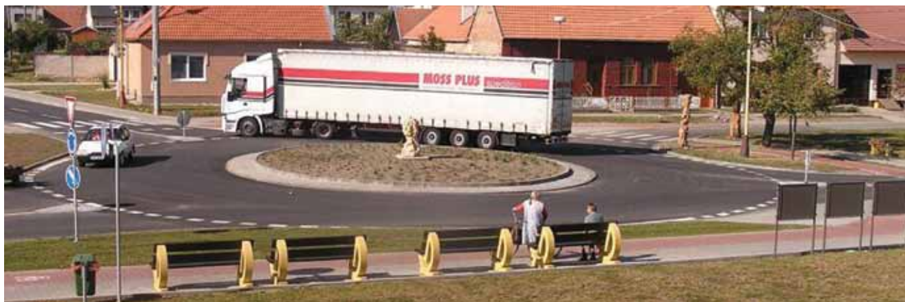
obr. 6 Malá okružní křižovatka na průtahu (Lužice, okr. Hodonín )
