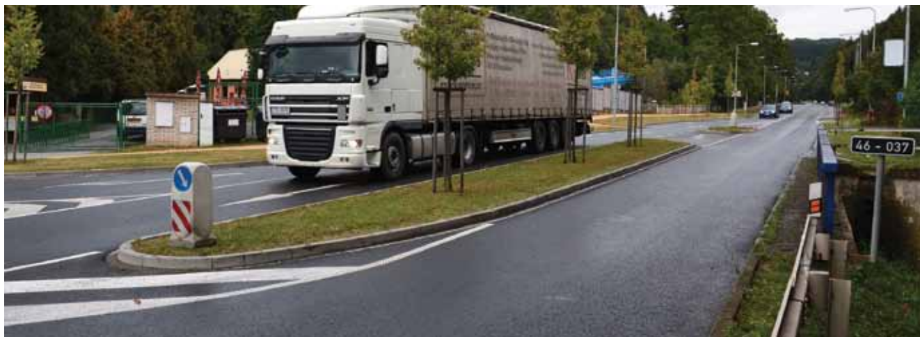
obr. 5 Dlouhý dělicí ostrůvek na průtahu obcí (Šternberk, I/46)
