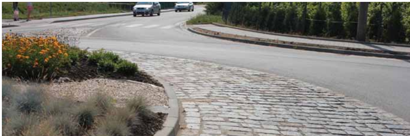
obr. 9 Kvalitní provedení prstence je nezbytné (Čejkovice, okr. Hodonín, sil. II/422 )
