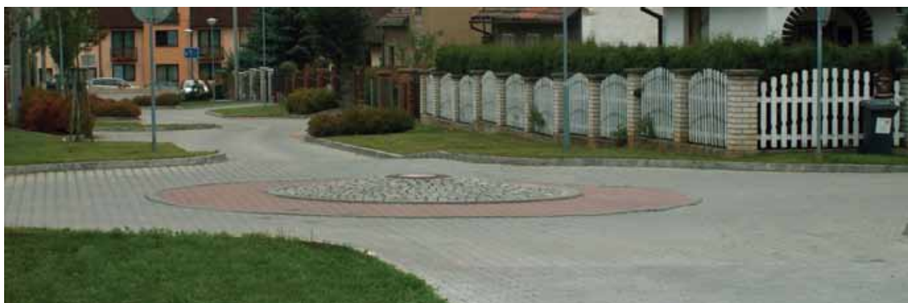
obr. 10 Miniokružní křižovatka s pojížděným středním ostrovem (Plzeň, křižovatka ulic Na Mezi a Podélná)
